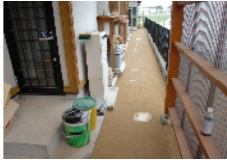
【N様邸透水性真砂土舗装工事(防草舗装)】
