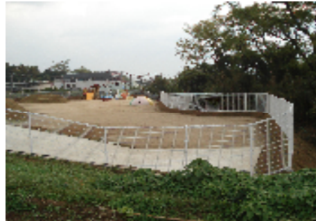
【某保育園整備工事】
