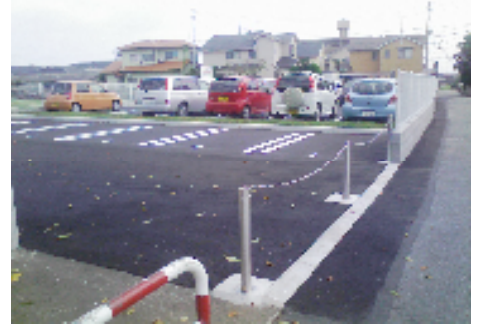
【某保育園駐車場舗装工事】
