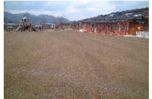
【某幼稚園整備工事】
