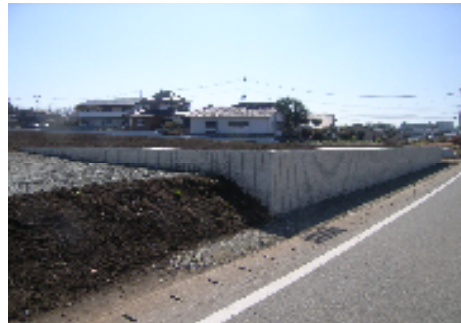
【某施設敷地造成工事】
